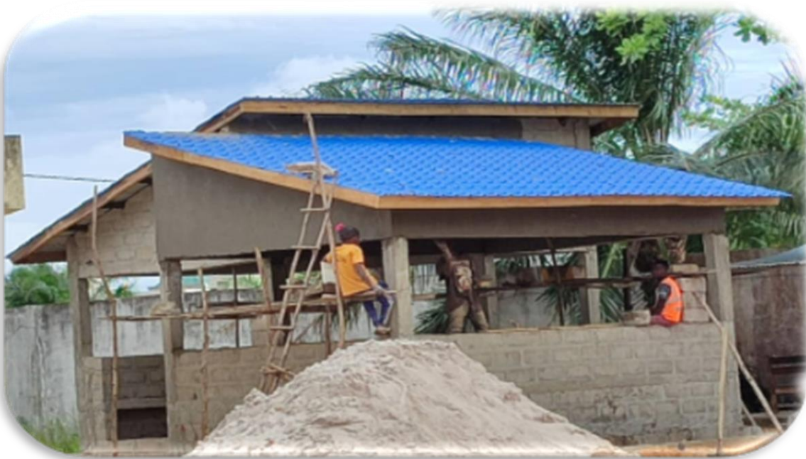
Pose de la toiture
