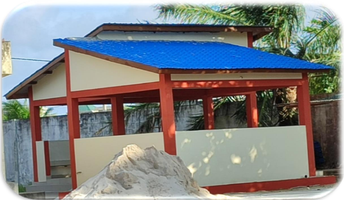
Fin des travaux de peinture
