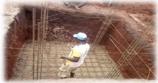
Fouille et ferrailage pour béton de propreté
