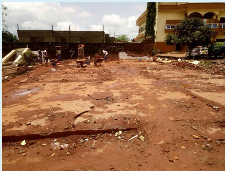
Les barrières de chantier posées, les maçons, l'architecte et le technicien mesurent l'implantation du futur bâtiment afin de vérifier que l'espace nécessaire à la construction est bien respecté.
