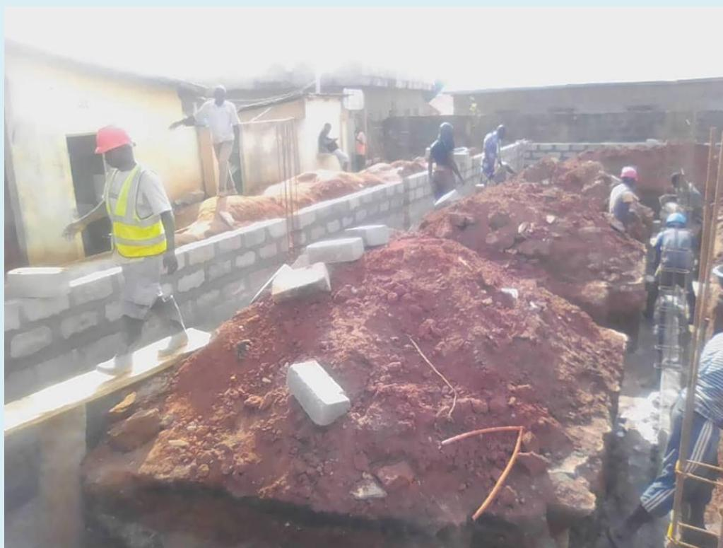
Les fouilles sont terminées et les murs se montent peu à peu. Les bases sont protégées de l'humidité par du goudron.
