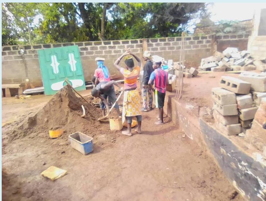
Les camions se succèdent, sable, sacs de ciments, ferraillage... Les fouilles se terminent à peine que déjà les fondations sont coulées, les parpaings fabriqués sur place sèchent au soleil. Une trentaine d'ouvriers sont à l'œuvre... Presque tout ce fait manuellement : seule machine mécanique, une grosse bétonnière tourne sans cesse...
