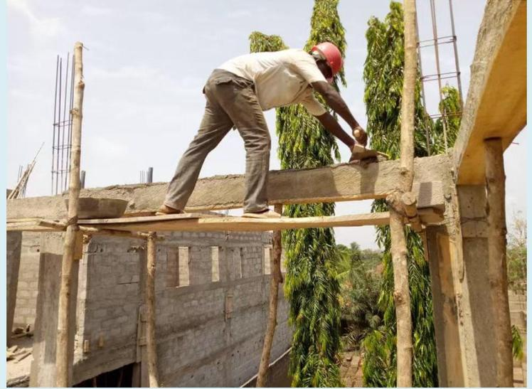
Les murs du deuxième niveau sont en train de s'achever, l'étape suivante sera la construction du toit : plus de 700 m<sup>2</sup> à couvrir. Des centaines de bambous de 4m pour soutenir poutrelles et hourdis.
