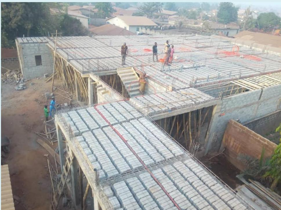
Coulage de la chape avant la construction du 2e niveau. Des dizaines de mètres cubes de béton sont montés à la main sur 5 m de haut. Cela montre le mérite et la volonté de ces ouvriers de mener à bien ce chantier en pleine nuit, afin que la dalle ne sèche pas trop vite sous la chaleur du jour...
