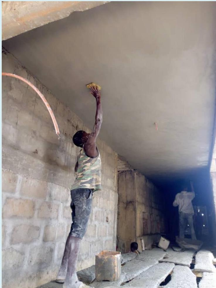
Le titanesque chantier avance jour après jour. La chape étant à présent totalement sèche, les bambous et troncs d'arbres sont enlevés et emportés, les menuiseries sont livrées pour fabriquer les encadrements de portes, les finitions de murs et plafonds (hauts de 4m) se poursuivent sur des milliers de m<sup>2</sup> de béton brut.
