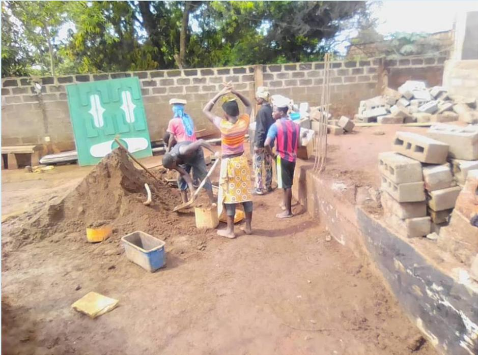
Les camions se succèdent, sable, sacs de ciments, ferrailage... Les fouilles se terminent à peine que déjà les fondations sont coulées, les parpaings fabriqués sur place sèchent au soleil. Une trentaine d'ouvriers sont à l'œuvre... Presque tout ce fait manuellement : seule machine mécanique, une grosse bétonnière tourne sans cesse...
