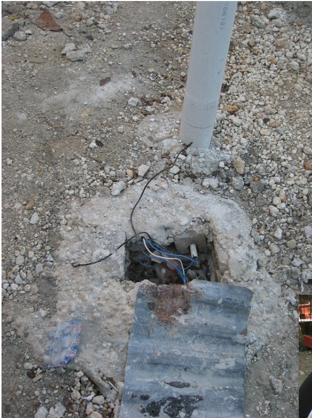
Photo - Un branchement électrique....
