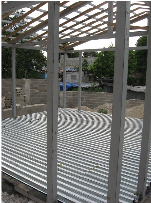
Photo - Fin de journée au 1er chantier
