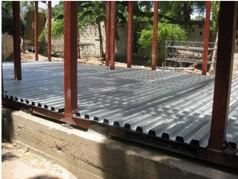
Photo - Le plancher fini de poser....
