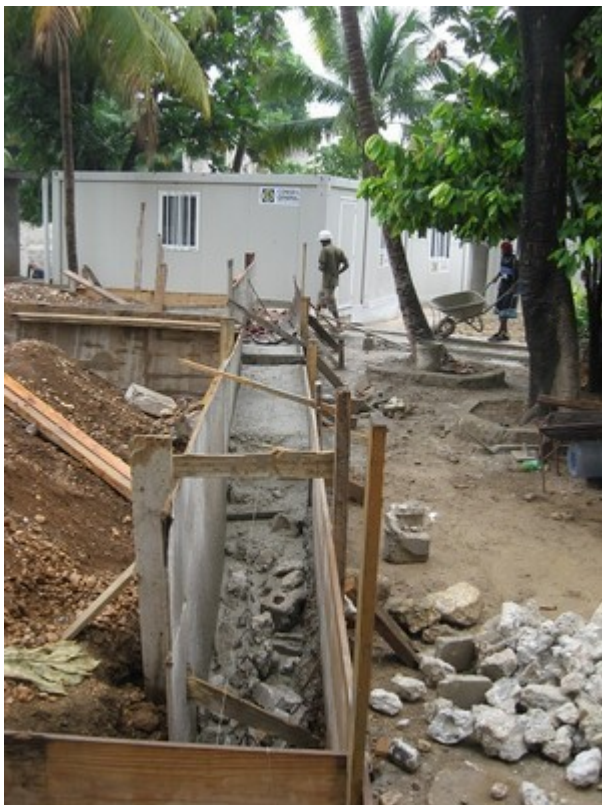
Photos - Les fondations avancent....
