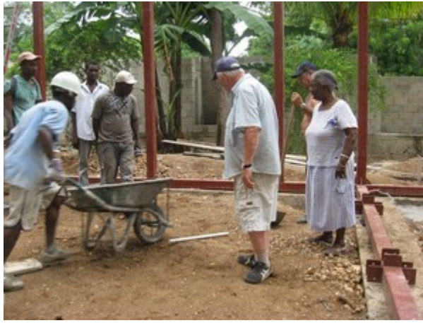
Photo - Fin de journée, tournée des chantiers
