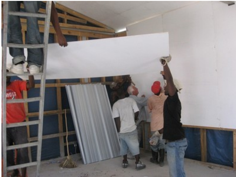
Photo - Mise en place de l'habillage intérieur de la 1ère structure.
