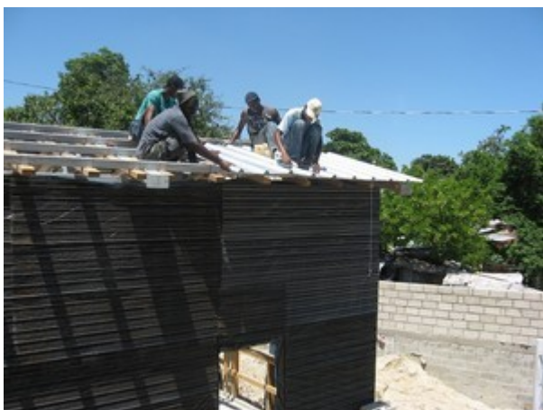
Photos - Préparation des murs pour recevoir un crépi et début de pose du toit
