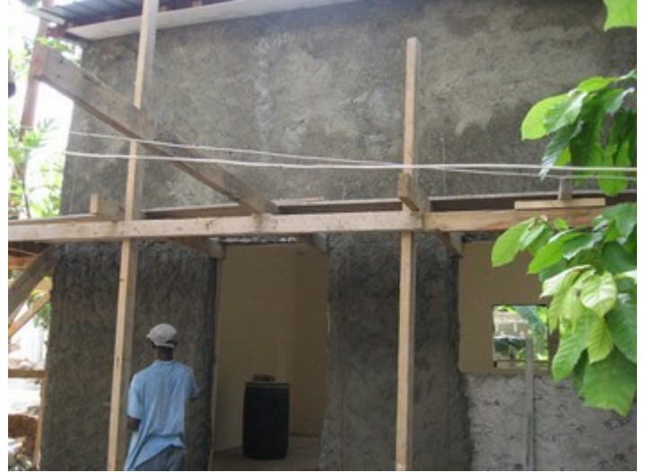
Photos - Différentes étapes d'avancement du crépis...
