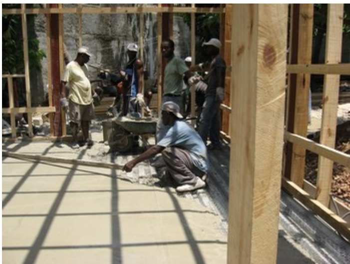
Photos - Coulage de la dalle, avant, pendant (contrôle de Georges et Jean-Jean)
