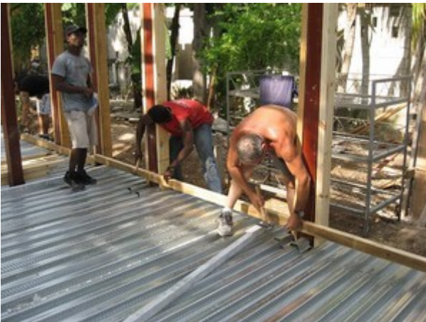
Photos - Mise en place des bois support - Un petit coup de propreté.
