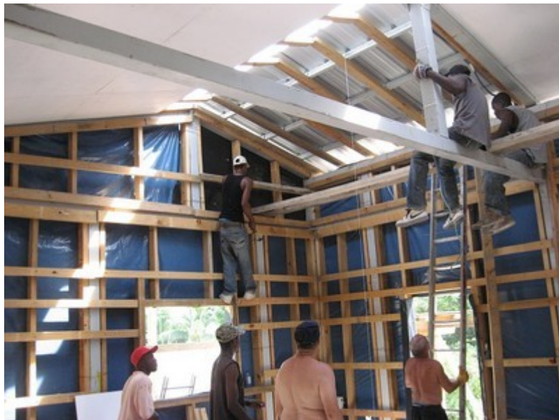
Photo - Les travaux de l'intérieurs de la 1ère structure
