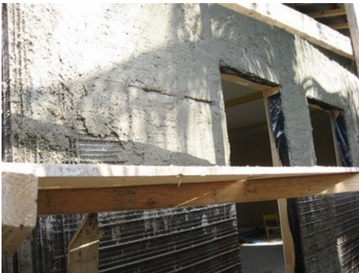
Photos - Différentes étapes d'avancement du crépis...
