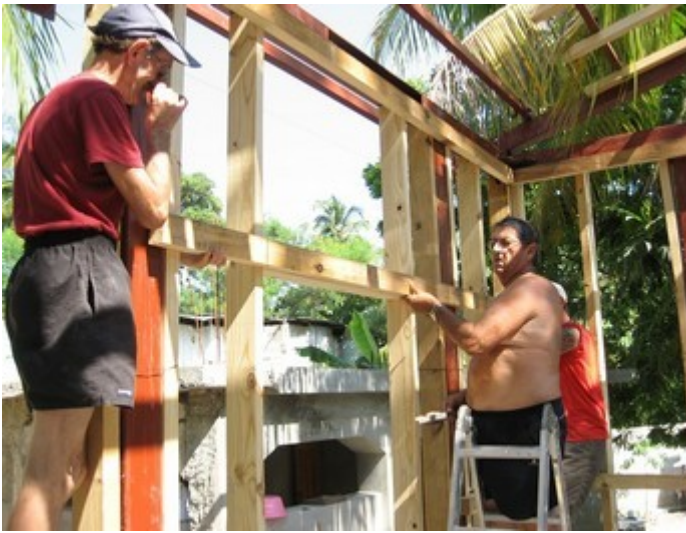
Photos - Pose des bois au niveau
