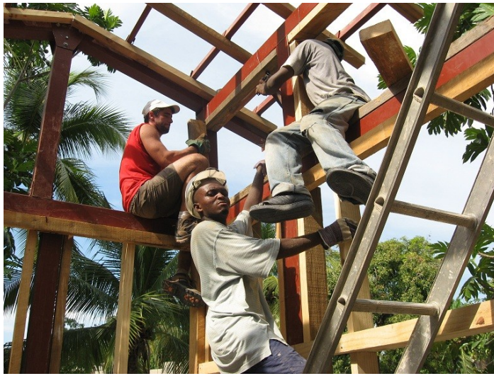
Photo - Les derniers morceaux de la structure de l'école
