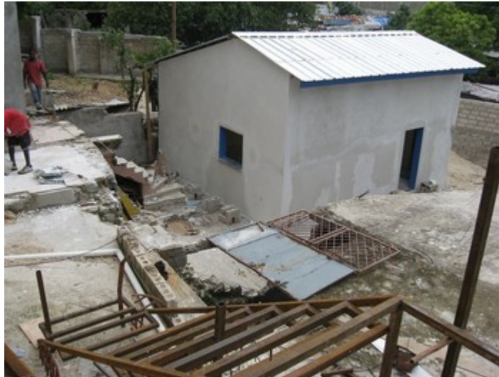
Photo - L'échafaudage est démonté.
