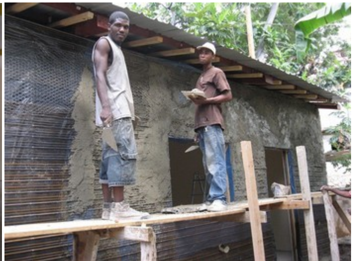
Photos - La crèche, fin du crépis fin et début pose du carrelage.
