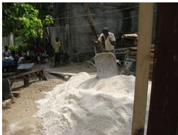
Photo - Pendant ce temps, préparation du tas de sable pour le béton de la dalle
