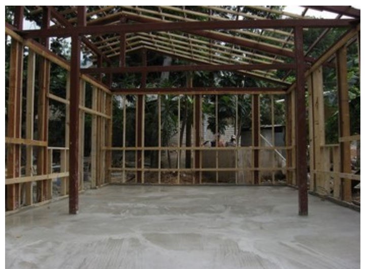
Photos - Coulage de la dalle, avant, pendant (contrôle de Georges et Jean-Jean)
