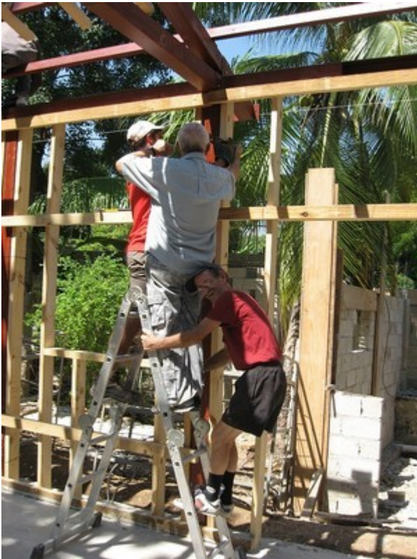
Photos - Pose des bois au niveau
