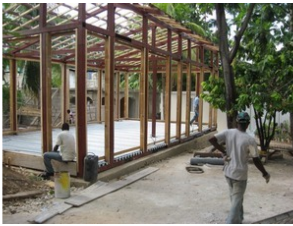
Photo - Fin de journée sur la 2ème structure
