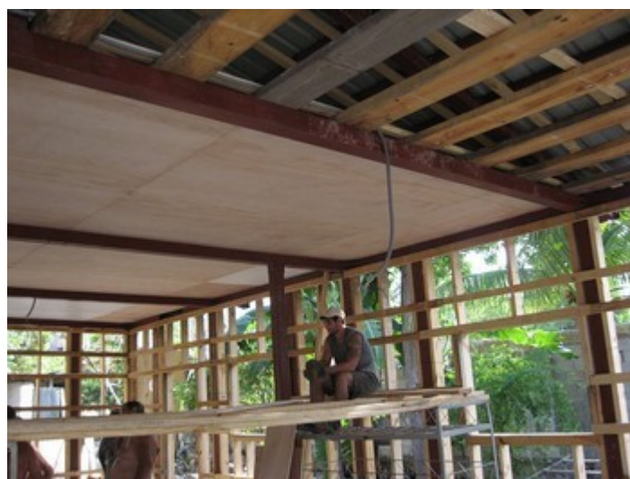
Photos - Le petit coté du toit ....- Le double plafond au début.....
