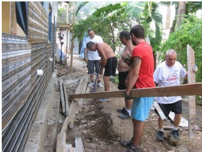
Photo - Fin de démontage de l'échaffaudage et mise en place pour l'école
